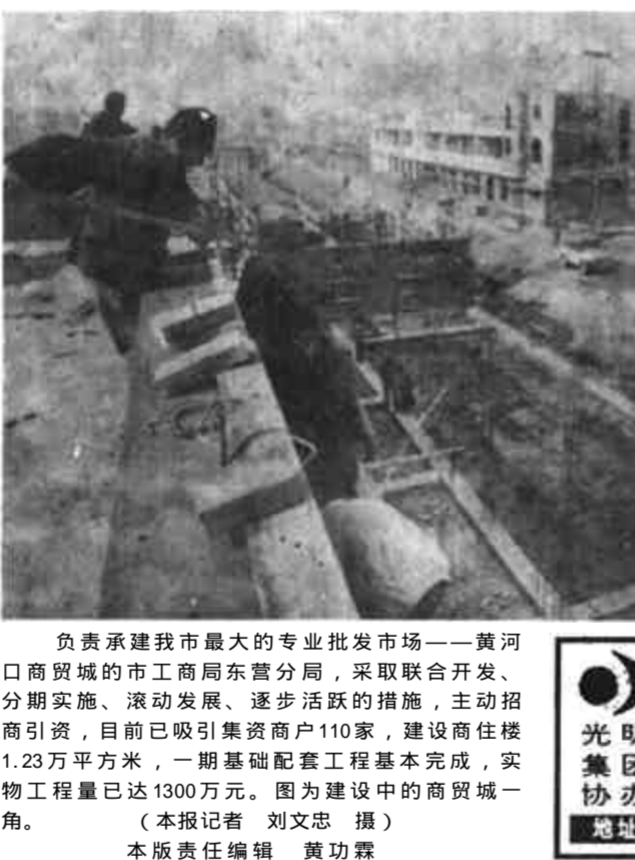
负责承建我市最大的专业批发市场——黄河口商贸城的市工商局东营分局，采取联合开发、分期实施、滚动发展、逐步活跃的措施，主动招商引资，目前已吸引集资商110家，建设商住楼1.23万平方米，一期基础配套工程基本完成，实物工程量已达1300万元。图为建设中的商贸城一角。（本报记者 刘文忠 摄）
